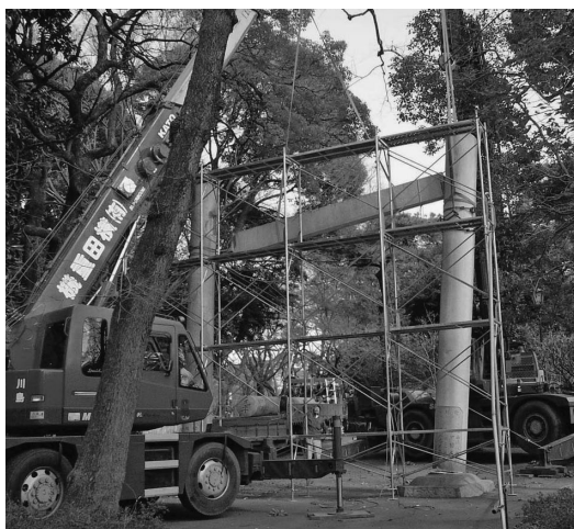
解体中の石鳥居
